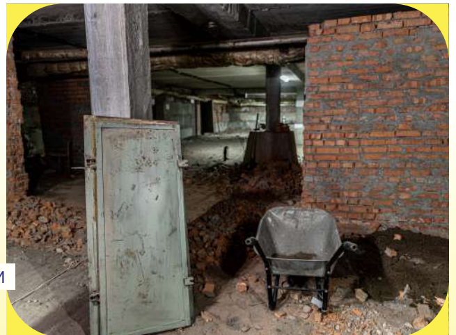
Зараз тривають ремонтні роботи, аби забезпечити цих учнів просторим і комфортним укриттям
